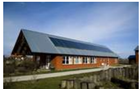
Solfangere på bygning i Munksøgaard-bebyggelsen (foto: Rune Johansen)
