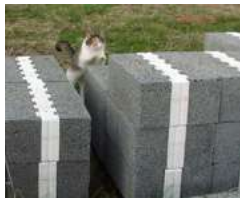
Effektiv afbrydelse af kuldebroer, fx med brug af sandwich-fundamentsblokke, er nødvendigt for at opnå lavt energiforbrug. Foto: Rune Johansen
