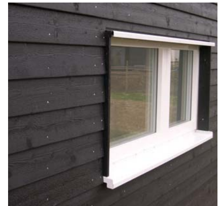
Facadebeklædning med vinduesåbning.
