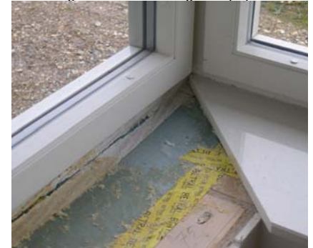
Placering af folie til luft- og dampspærre.
