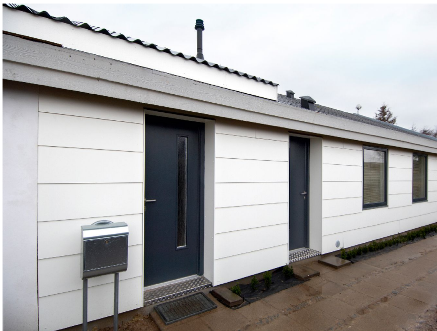
Den sydvendte facade efter energirenovering (Foto Henrik Tommerup, DTU Byg)
