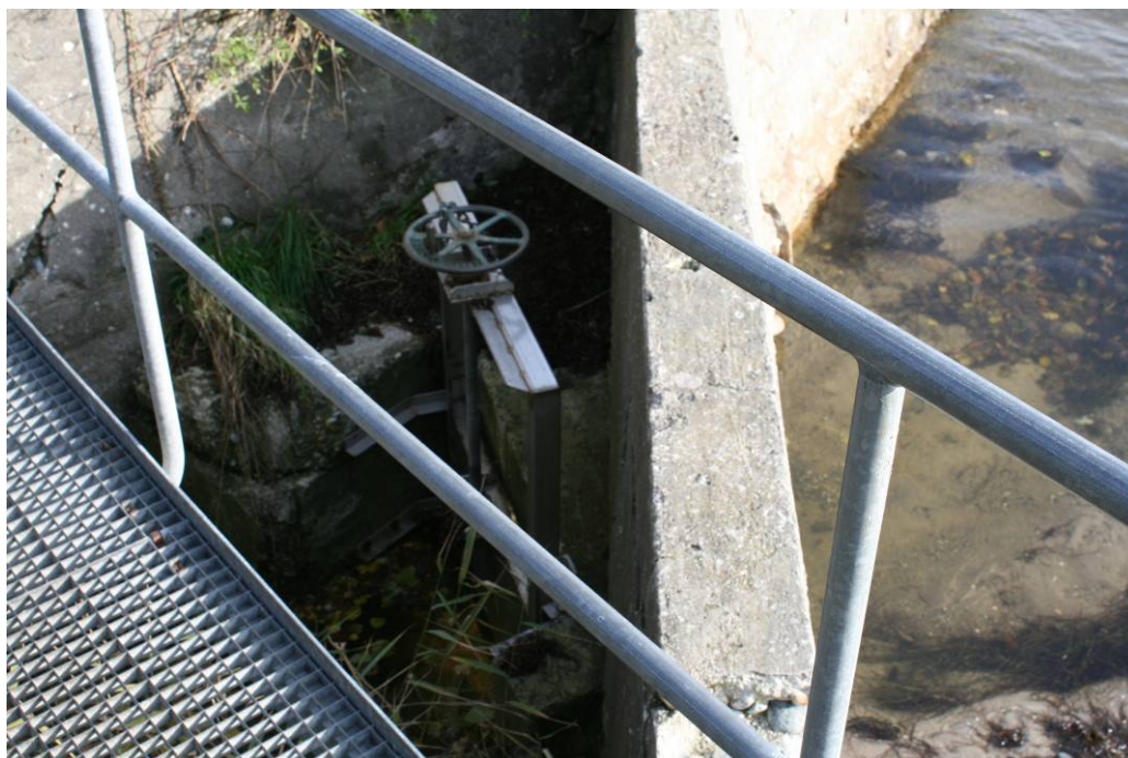
Figur 4-11 Bygværk ved udløb af Krusebæk, der kan anvendes til at lukke for Kruse Bæk så høj vandstand ikke forplanter sig ind til arealerne bag bygværket.
