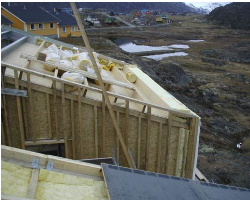
Et kig på den endnu åbne tagkonstruktion over nordlig bokasse
