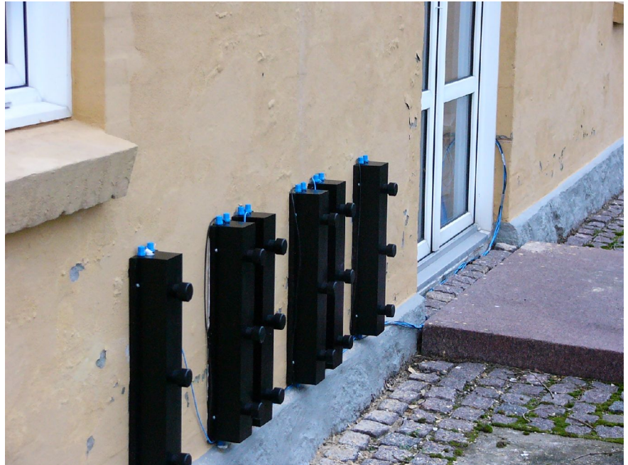
Pilotforsøg. Elektroder placeret på ydersiden af muren.
