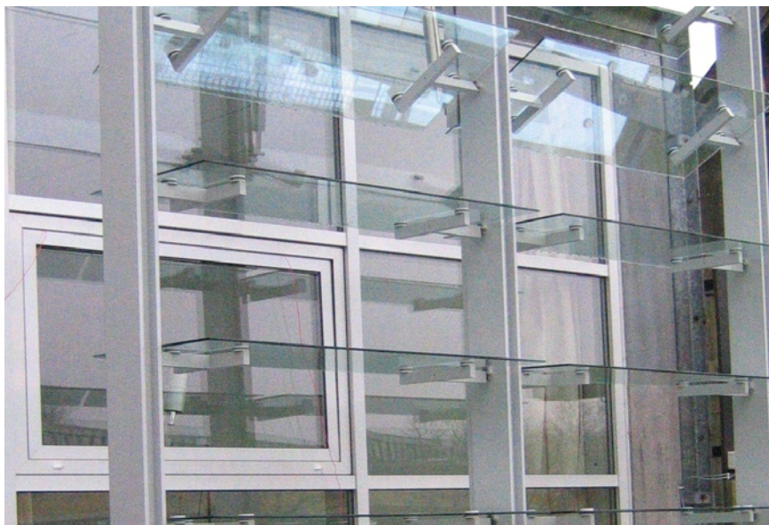
Solafskærmningssystem med lamellerne i position til optimeret lysindfald på overskyet dag (Foto Jacob B. Laustsen, DTU Byg)
