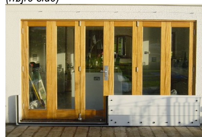
Skinne monteret ved dør umiddelbart før forsats monteres (venstre side) og efter (højre side)
