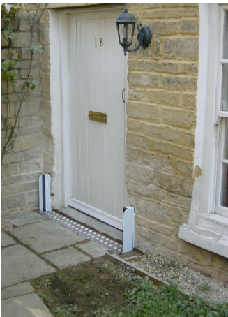
Skinne monteret ved dør
