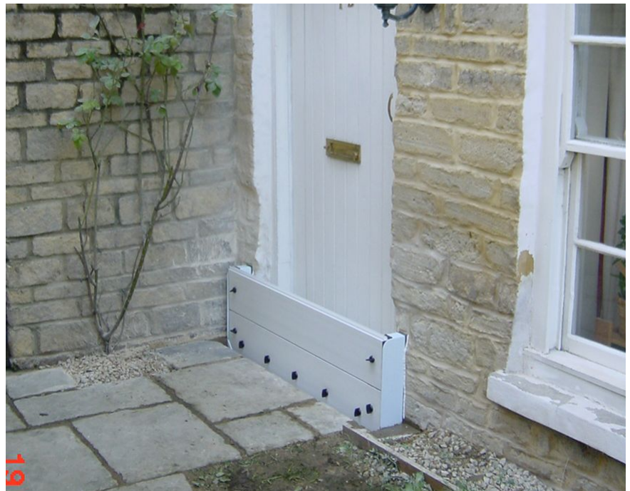
Forsats monteret ved stormflodsvarsel
