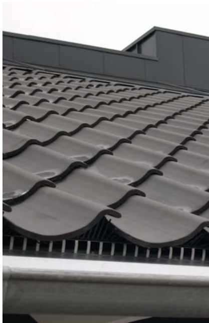
Rygning og ventilationsskorsten.
