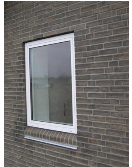
Aluinduer og murede sålbænke.
